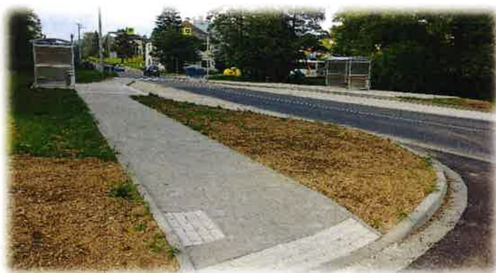
Oprava chodníku a nové autobusové zálivy
